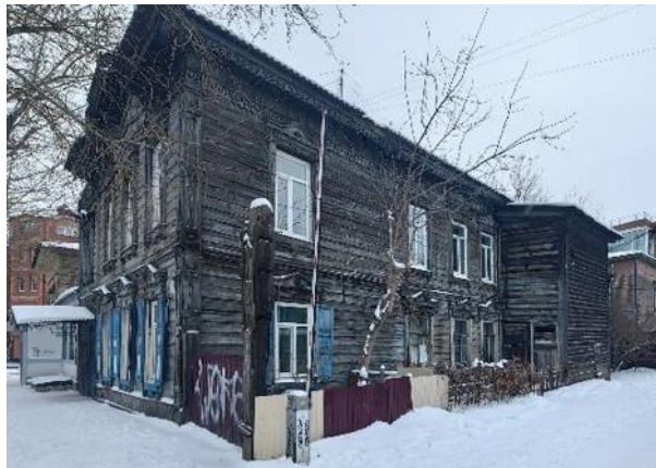
Боковой северо-западный фасад Вид с северной стороны
