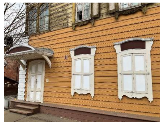
Дверь юго-западного пристроя и окна первого этажа с главного юго-восточного фасада
