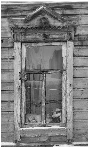
Окно первого этажа бокового северо-западного фасада
