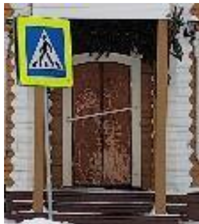
Дверь первого этажа скошенного угла главных фасадов Вид с юго-восточной стороны
