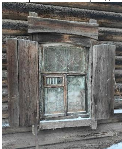
Окно первого этажа с дворового юго-западного фасада
