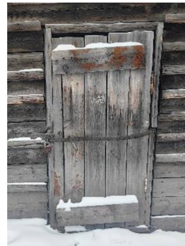
Дверь северо-западного прируба с бокового северо-западного фасада
