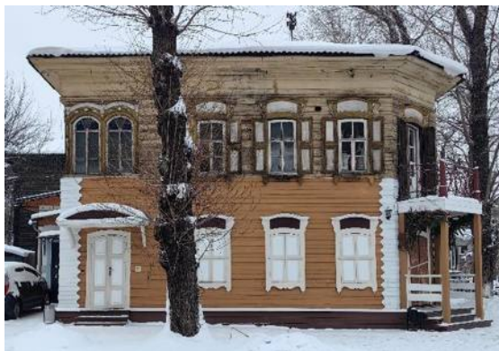
Главный юго-восточный фасад
