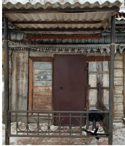
Дверь северо-западного прируба с северной стороны
