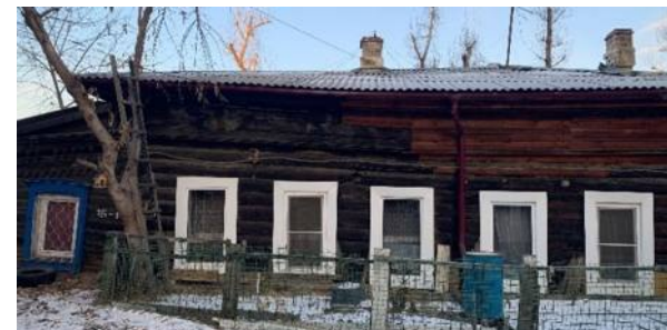
Дворовой юго-западный фасад
