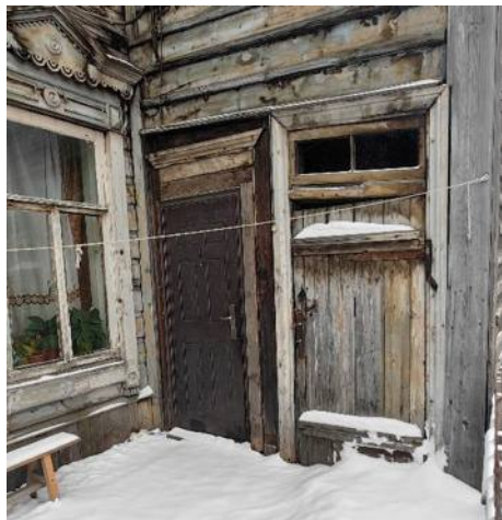
Двери северо-западного прируба с главного северо-восточного фасада
