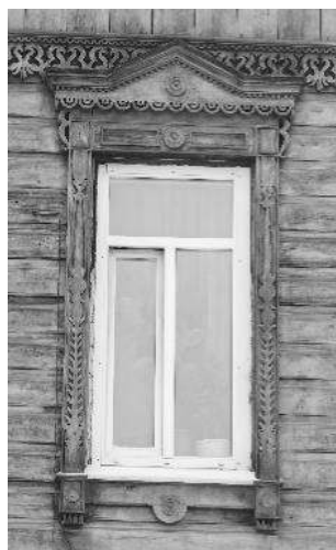
Окно второго этажа главного северо-восточного фасада
