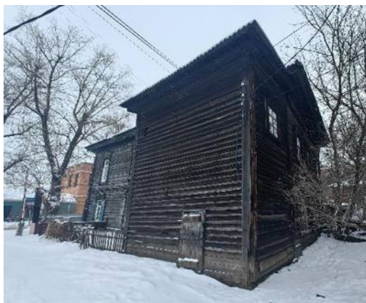
Боковой северо-западный фасад Вид с западной стороны
