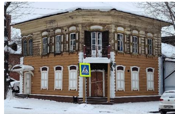
Главный юго-восточный фасад и главный северо-восточный фасад Вид с восточной стороны
