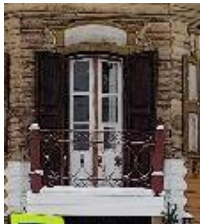
Балкон и дверь второго этажа скошенного угла главных фасадов Вид с юго-восточной стороны
