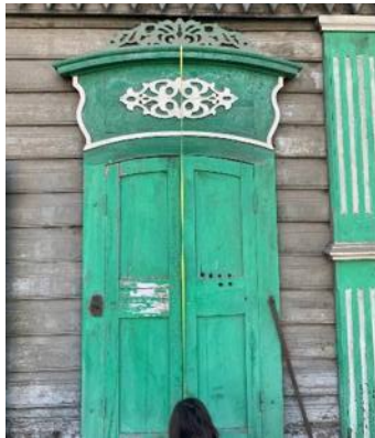
Окно главного северо-восточного фасада
