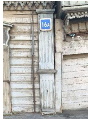
Пилястра главного северо-восточного фасада
