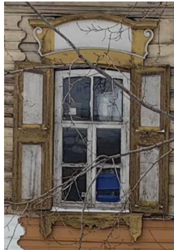
Окно второго этажа главного северо-восточного фасада
