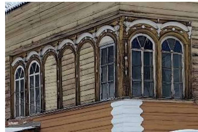
Галерея второго этажа юго-западного пристроя
