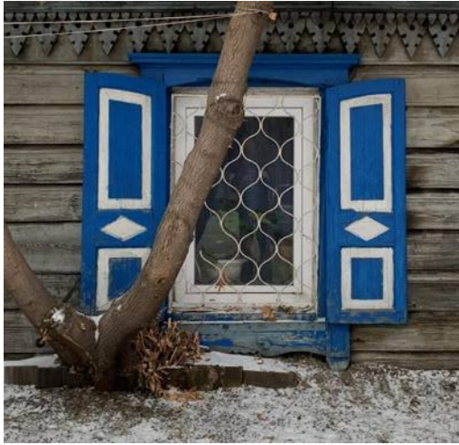
Окно северо-западного прируба с северной стороны
