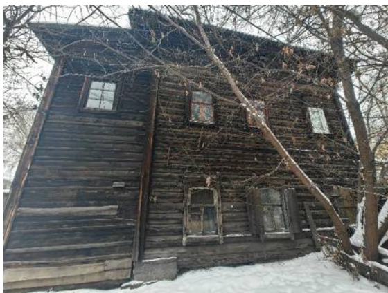
Дворовой юго-западный фасад
