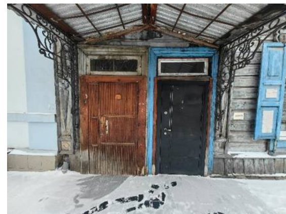
Двери юго-восточного прируба с главного северо-восточного фасада
