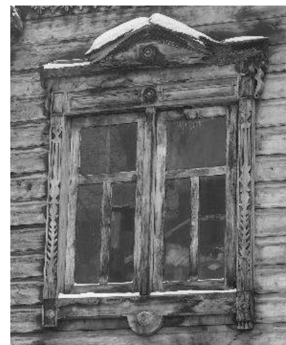
Окно второго этажа юго-восточного прируба с главного северо-восточного фасада
