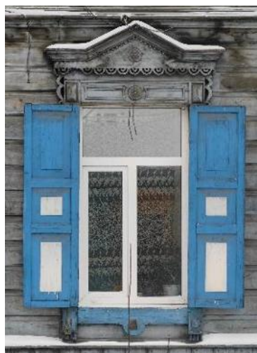
Окно первого этажа главного северо-восточного фасада
